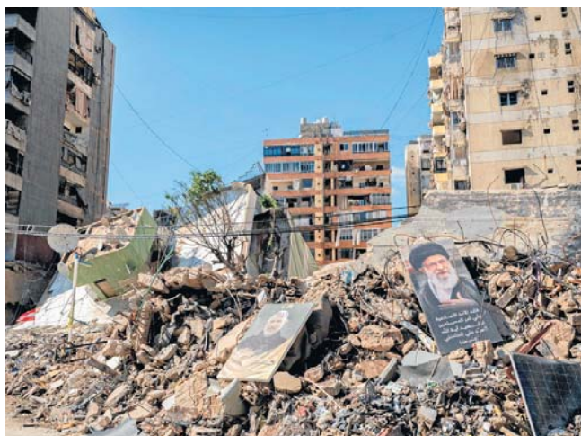
Zniszczone budynki na południowych przedmieściach Bejrutu. Tysiące mieszkańców po atakach trwających od marca zostało zmuszonych do opuszczenia swoich domów
