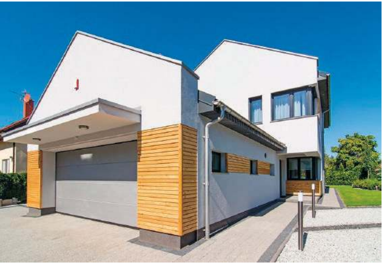
W kategorii domów jednorodzinnych internauci największego poparcia udzielili budynkowi na wrocławskim osiedlu Złotniki,
