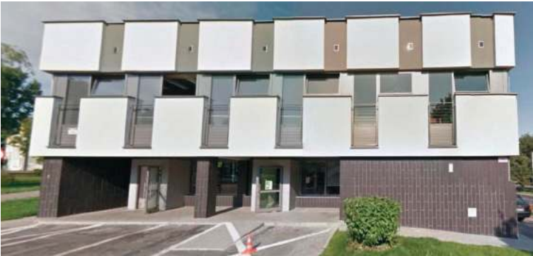
W kategorii „Remonty i modernizacja” wśród zgłoszonych obiektów znalazł się pawilon usługowy LSM, mieszczący się przy ul. Leonarda 16 w Lublinie. Budynek przeszedł termomodernizację z wymianą ślusarki okiennej i drzwiowej, docieplono ściany, a także zmieniono kolorystykę obiektu. Wykonawca prac była firma Jobi System Maciej Cykowski z Józefowa.
