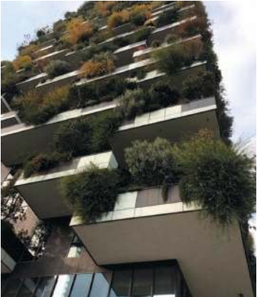
Jednym z ciekawszych obiektów ubiegających się o nagrodę w kategorii „Budynki mieszkalne” jest ten z ukraińskiej miejscowości Stryj. Nowoczesny kompleks mieszkaniowy charakteryzuje się kompaktowym i niepowtarzalnym układem apartamentów z przestronnymi tarasami, na których znalazło się mnóstwo roślinności.
