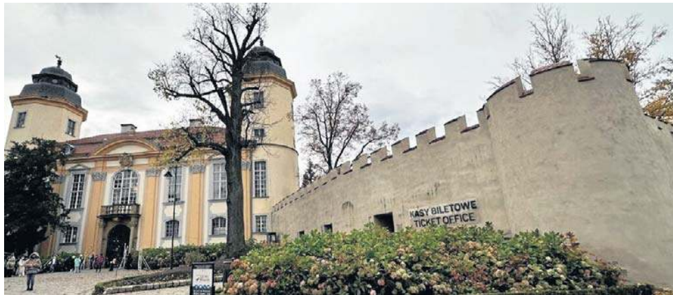
Budynek toalet jest wkomponowany w przestrzeń, która opada w stronę wąwozu
