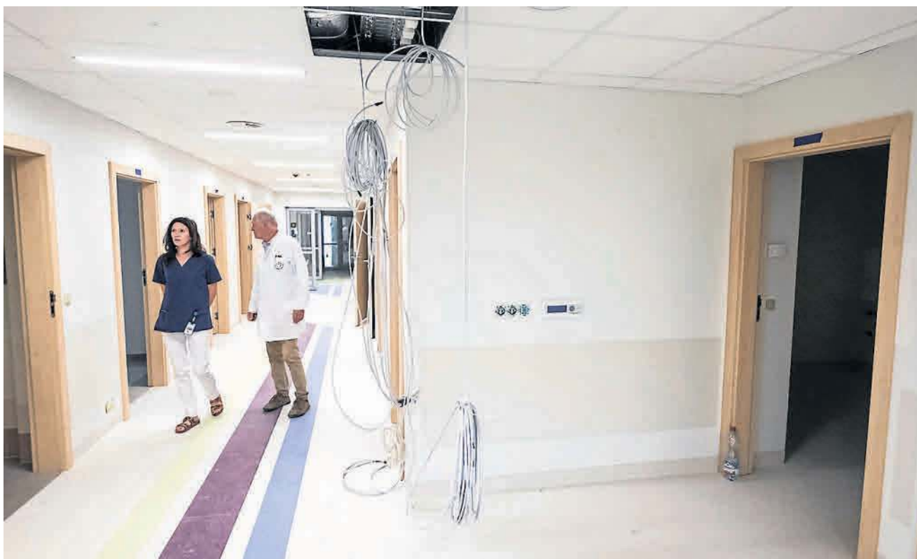
Budynek przy ulicy Szpitalnej został już postawiony. Pozostał jeszcze zakup wyposażenia i prace wykończeniowe.
