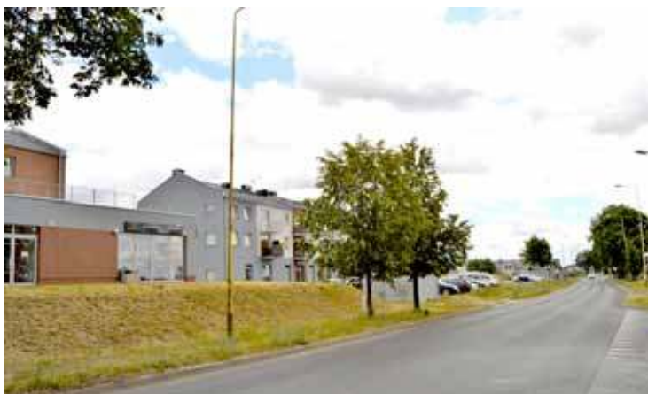
Niebawem rozpocznie się budowa chodnika przy ul. Niepodległości
