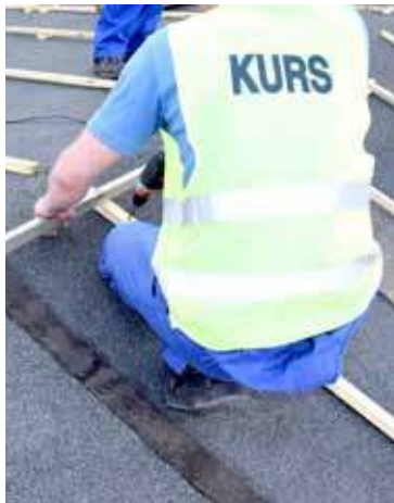
Osadzeni w Zakładzie Karnym zdobywają umiejętności potrzebne w zawodzie dekarza
