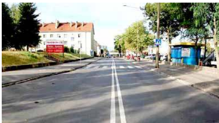
Do wtorku 9 lipca firmy zainteresowane wykonaniem przebudowy ul. Pierwszej Brygady mogą składać swoje oferty
