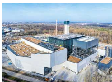
• Gorący rozruch w spalarni śmieci na Targówku
