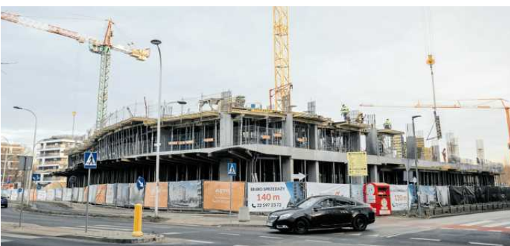
• Budowa osiedla przy ul. Światowida na Białołęce, styczeń 2025 r.
