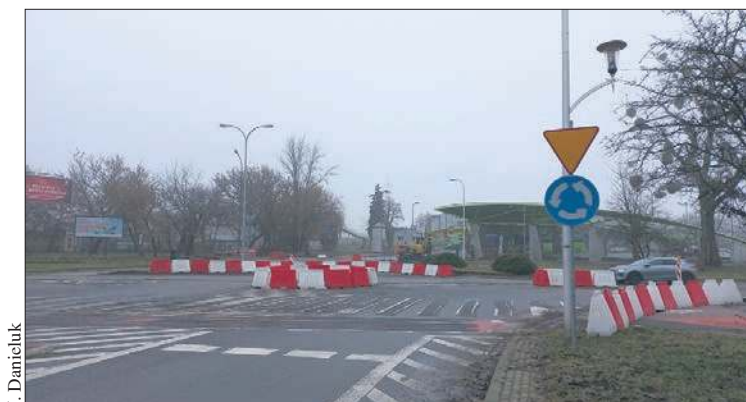
Trwa przebudowa ul. Chopina na wysokości dworca autobusowego
