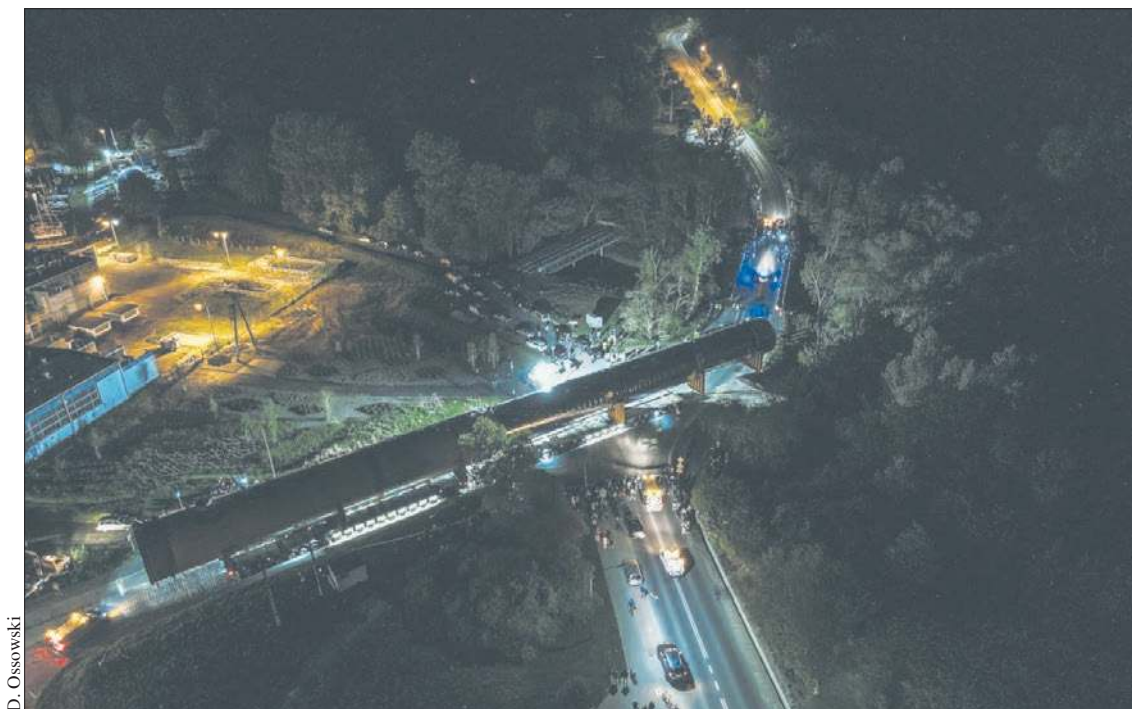
Transport kolumny Wash Tower na plac budowy instalacji Olefiny III
