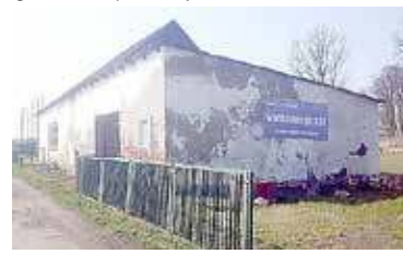
Dzięki podjęciu prac obecna budowa zostanie wyburzona, a w jej miejsce zostanie postawiona nowa
