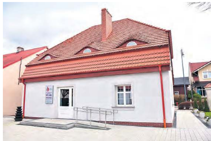
Tzw. organistówka przeszła w ostatnich latach kapitalny remont. Prace sfinansowały Gmina Śliwice i tutejszy SPZOZ.
