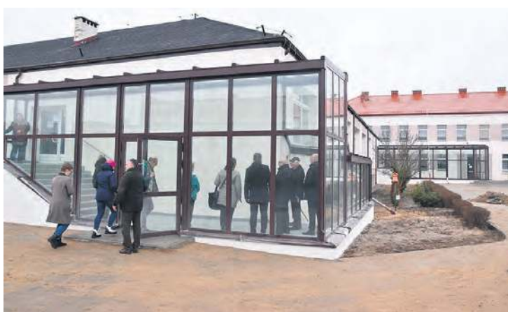
Łącznik przy Gminnej Bibliotece Publicznej.
