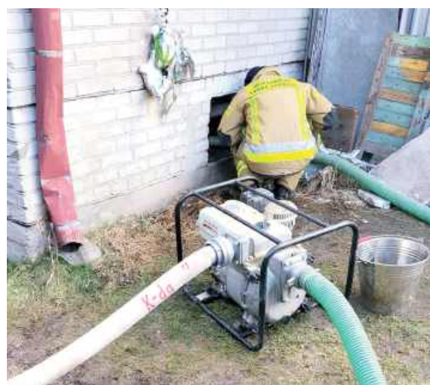
Wyjazd do zalanej piwnicy w budynku mieszkalnym w miejscowości Drożdżak, 26 lutego, godz. 8.01
