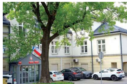
Nowa siedziba CUW i straży miejskiej
