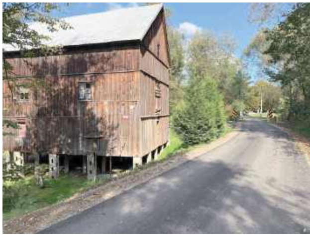
Dzięki wykorzystaniu dotacji z FOGR-u gminie udało się wyremontować kolejną drogę dojazdową do pól
