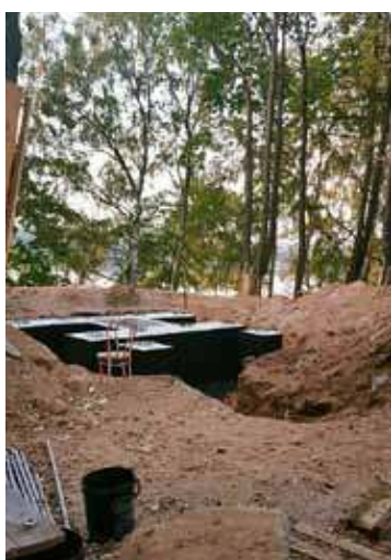
Nad jeziorem Ińsko trwa budowa wieży widokowej
