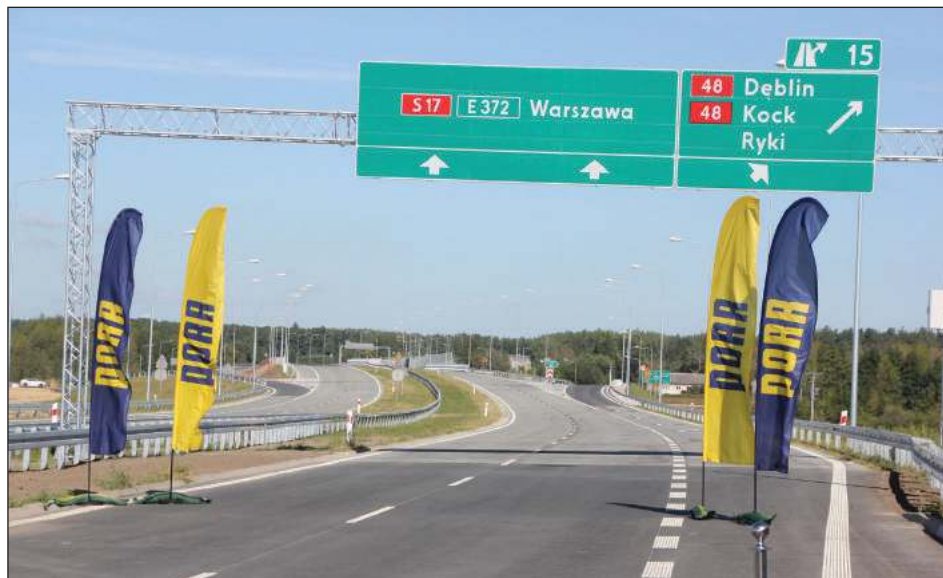
➤ Obwodnica Ryk na wysokości Moszczanki. Na obwodnicę zużyto 100 tys. m 3 betonu i 110 tys. ton masy bitumicznej. Współpracowało przy niej 273 firmy. W szczyście pracowało 800 pracowników, a w sumie 2,5 tys. osób.
