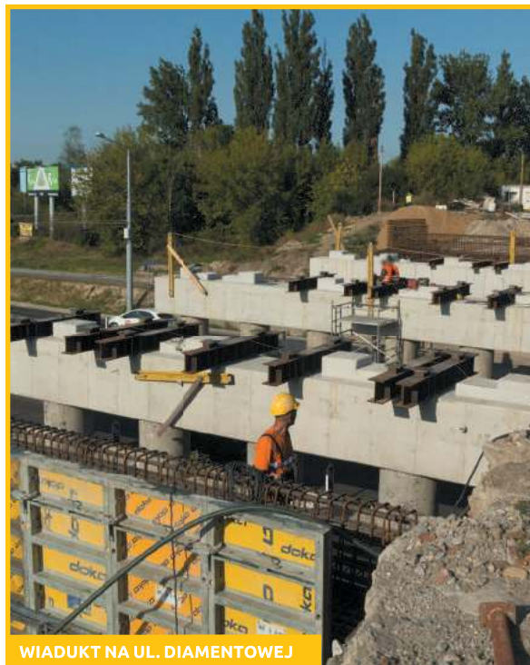
WIADUKT NA UL. DIAMENTOWEJ
