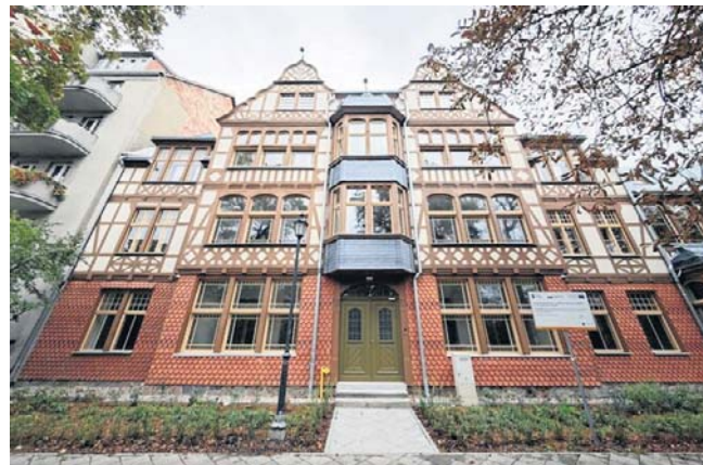
Tak wygląda kamienica przy Bydgoskiej 50-52 po remoncie
