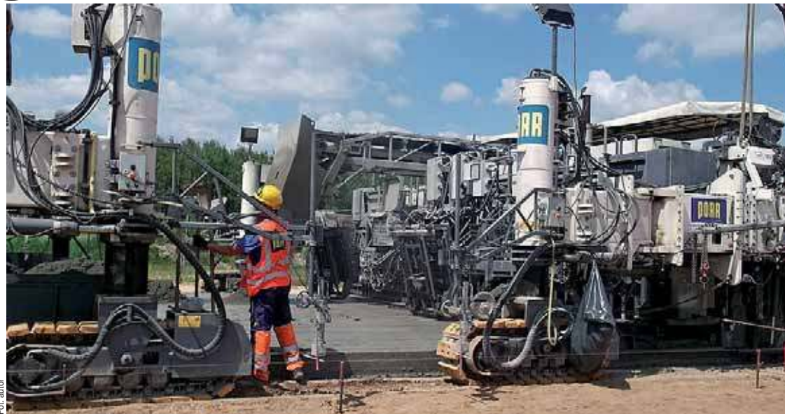
Kombajn do układania nawierzchni drogi ze specjalnego betonu
