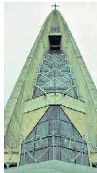
Przeprowadzone zostaną prace naprawcze powłoki betonowej oraz ścian żelbetonowych
