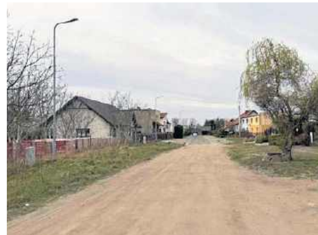
Budowa ulicy Owocowej w Wągrowcu. Burmistrz podpisała umowę z wykonawcą
