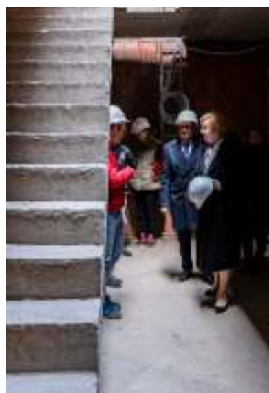
► Z wizytą na budowie Fot. UM Zabrze
