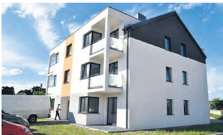
Zaraz po wyjściu z WDK część mieszkańców nowego bloku ruszyła z przeprowadzką.
