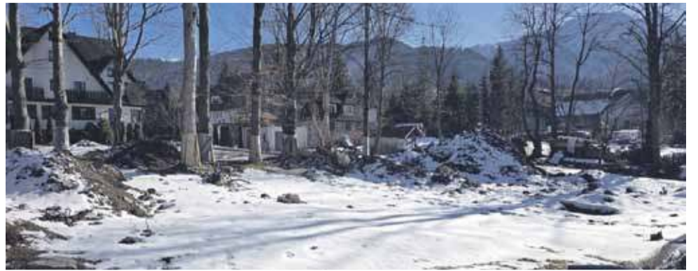
Budowa miasteczka rowerowego stanęła w martwym punkcie.
