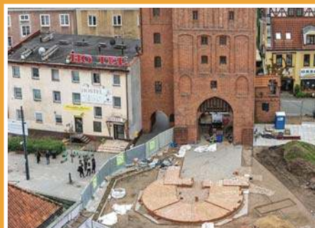
Trwa przebudowa historycznego miejsca \10
