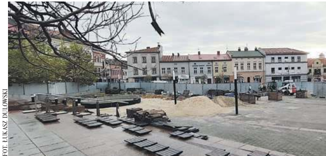
Trwa II etap przebudowy Rynku w Chrzanowie
