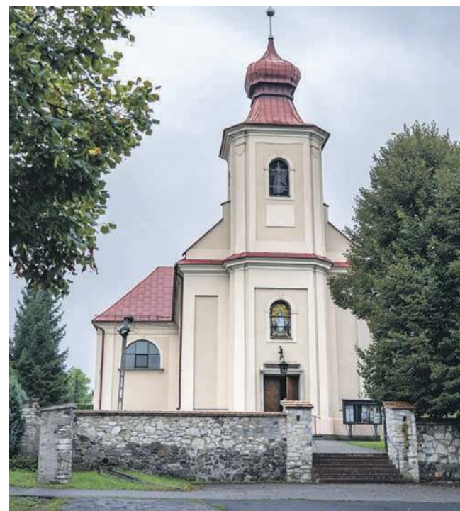
Fasada z głównymi drzwiami i górującą wieżą
