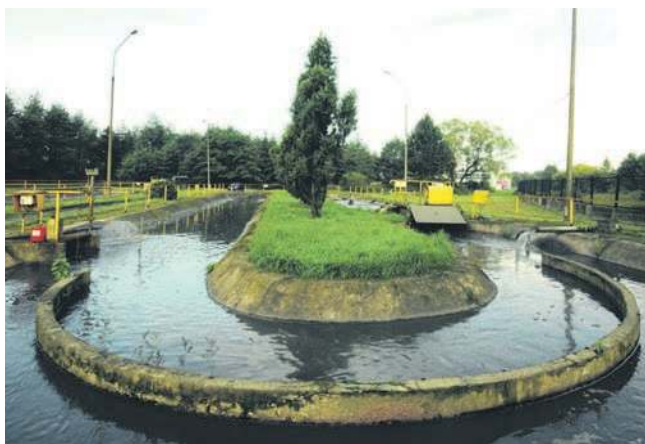
Istniejąca oczyszczalnia przy zakładach chemicznych w Alwerni
