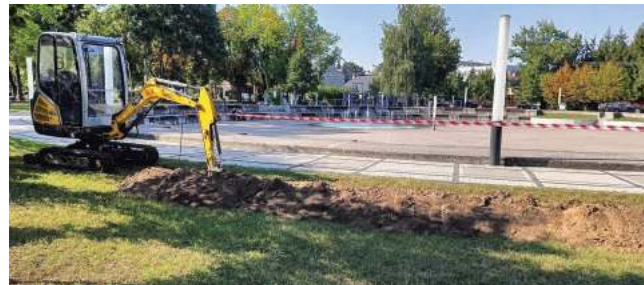
Prace przy fontannie w Parku Miejskim już się rozpoczęły
