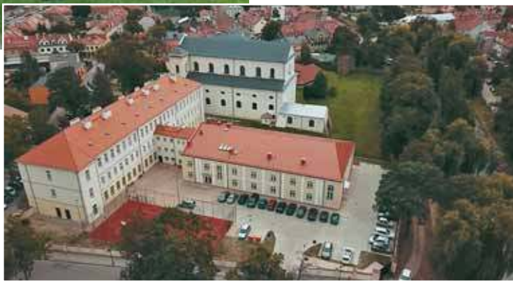
W budynku LO im. P. Skargi (tu widok z góry) trwa realizacja autorskiego programu pt. „Szkoła dobrych relacji”
