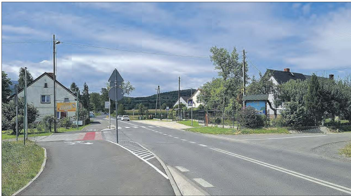
Zmodernizowana droga powiatowa w Moszczance
