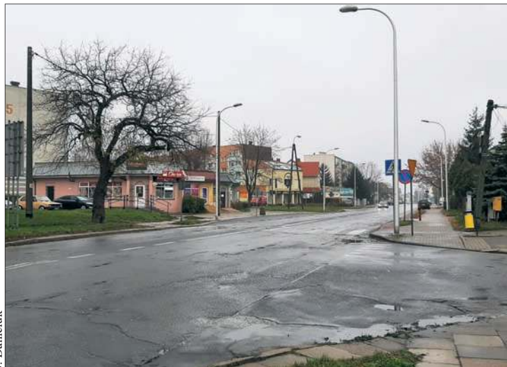
Trwają przygotowania do przebudowy ulicy Spółdzielczej
