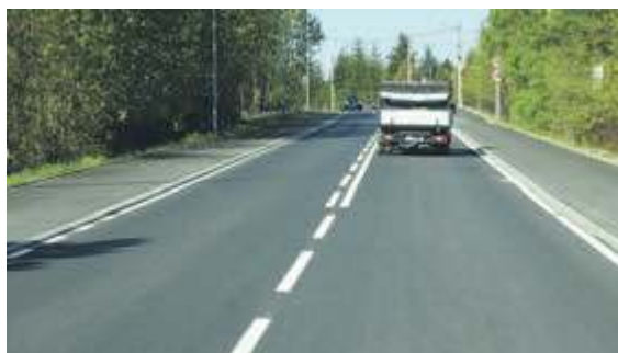
Orntonowice – w-wa ścieralna na TG, CPR i chodnikach, wykonane oznakowanie pionowe i poziome
