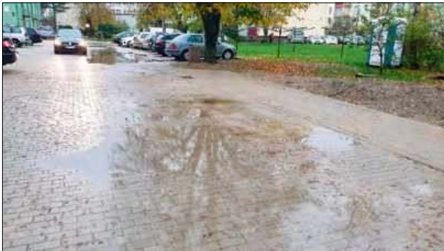
Zastoiny wody i brak miejsc parkingowych – to główne mankamenty.
