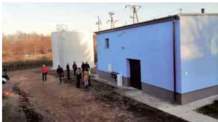
Hydrofornia po remoncie
