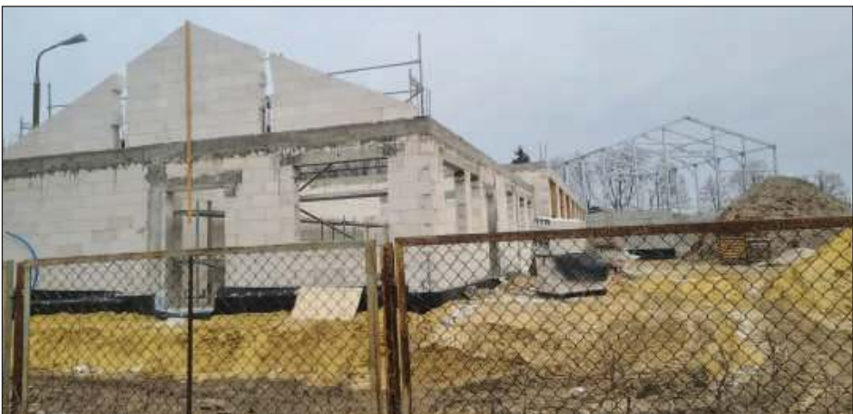
Budowa ma zakończyć się jeszcze w tym roku
