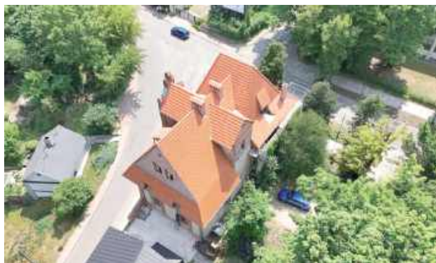
Najbardziej widocznym efektem zakońzonego etapu jest odtworzenie historycznej więźby dachowej oraz wykonanie nowego pokrycia z dachówki ceramicznej
