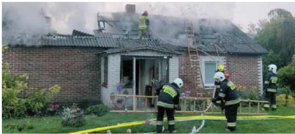
Strażacy musieli rozebrać dach budynku
