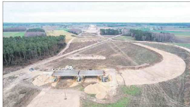
W ramach tego kontraktu wybudowanych zostanie ok. 14 km autostrady A2 o przekroju dwujezdniowym
