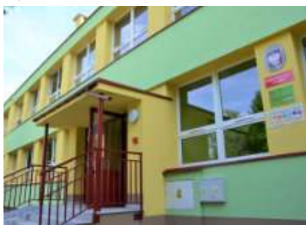
► Termomodernizacje kolejnych szkół i przedszkoli Fot. UM Zabrze
