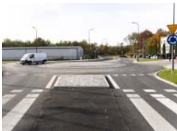
► Rozbudowa układu komunikacyjnego miasta Fot. UM Zabrze
