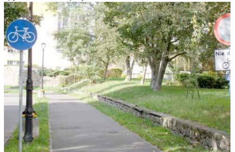
Gdzie w obowiązującym wzdłuż murów układzie komunikacyjnym jest miejsce dla pieszych
