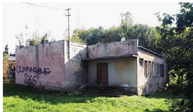
Niszczący w Śliwicy budynek zastąpi nowa świetlica
