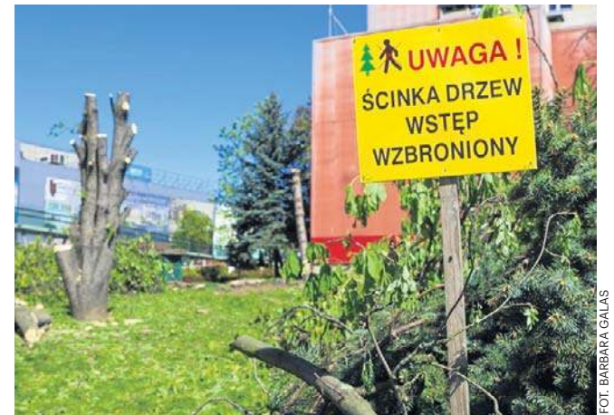
W miejscu, gdzie rosły drzewa przy al. Piłsudskiego powstanie parking dla pracowników firmy Orange
