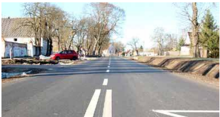
Firma Strabag zakończyła przebudowę drogi w Krępcowie. Na odcinku 2,5 km wymieniono nawierzchnię
