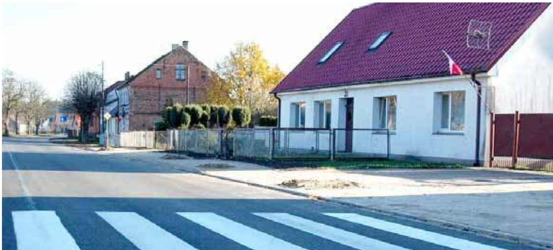
W ramach prac przebudowano również chodniki, oraz dojazdy do posesji
