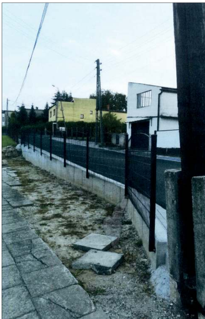
■ Mieszkaniec Tworkowa w korespondencji, która trafiła do redakcji Nowin, dołączył również zdjęcie. Fotografia przedstawia wygląd posesji po wykonaniu nowego muru oporowego. Na zdjęciu widzimy obszar, który należało wybrukować kostką FOT. CZYTELNIK
