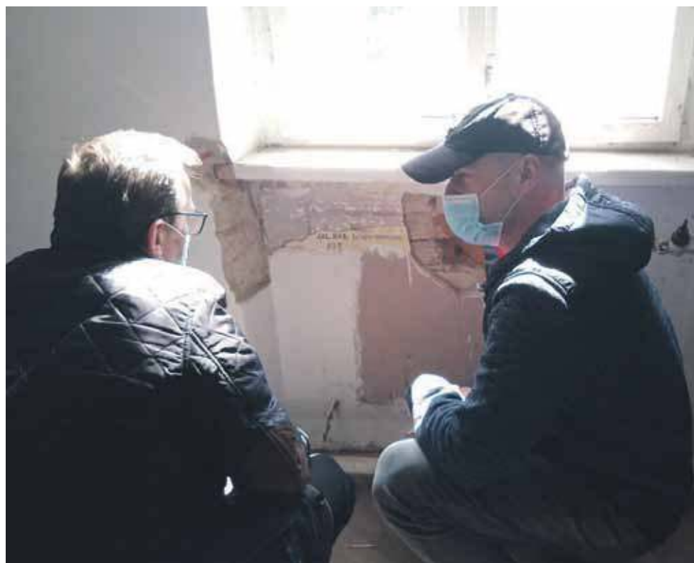
Pod grubą warstwą farby w Dworku w Tylmanowej odkryto pierwotne malowidła.
