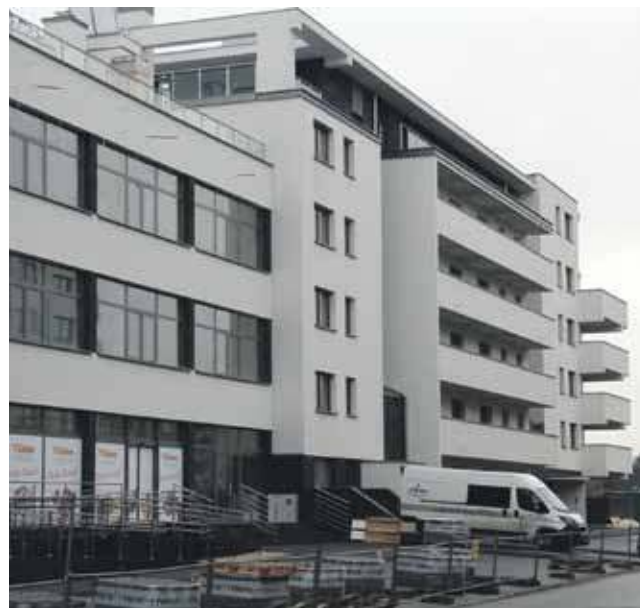
W części bloku nr 6 ma powstać klinika okulistyczna.
