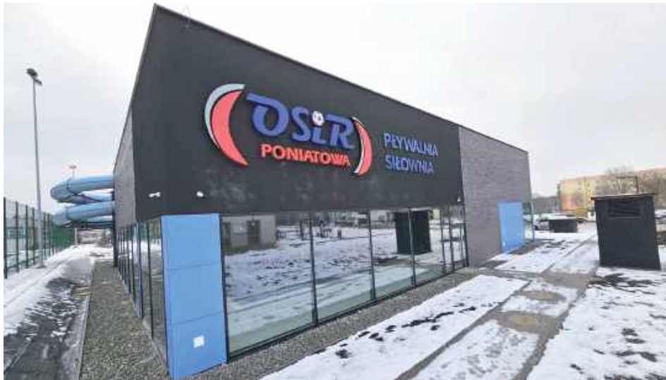
Obiekt stał się nowocześniejszy. Przede wszystkim dostosowano go do potrzeb osób niepełnosprawnych
