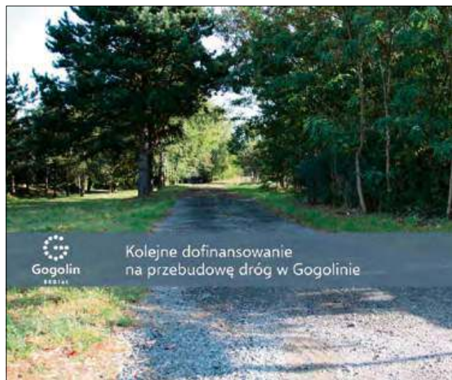
Ulica Johanna Krolla zostanie przebudowana.
