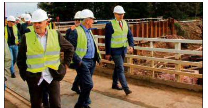
Postęp prac budowlanych na stopniu wodnym w Krapkowicach przyglądał się m.in. zastępca burmistrza Krapkowic Arnold Jozsko.
