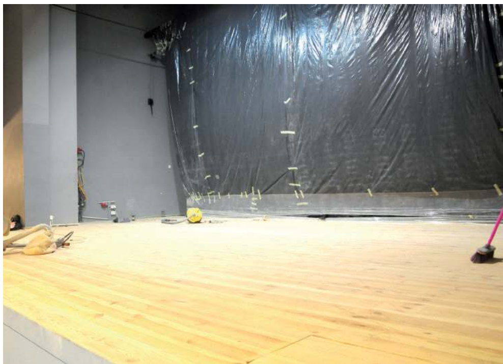
Modernizację przechodzi właśnie scena Nałęczowskiego Ośrodka Kultury. Podłoga została poddana cyklinowaniu, następnie zostanie zaolejowana i pomalowana na nowo
