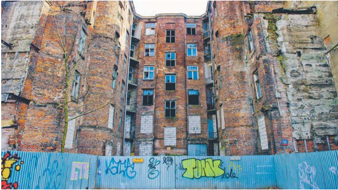
Fragment balustrady schodów z oficyny Waliców 14 znajduje się w sąsiednim lokalu nieczynnej restauracji | fot. Marcin Pegaz/Gazeta Polska
