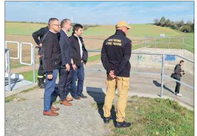
■ W Krzanowicach wojewoda wizytował m.in. suchy zbiornik przeciwpowodziowy na potoku Biała Woda FOT. UM KRZANOWICE
