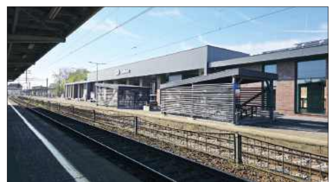
■ Widok dworca od strony torowiska
