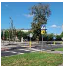
Na ul. Mickiewicza wykonano oznakowanie poziome
