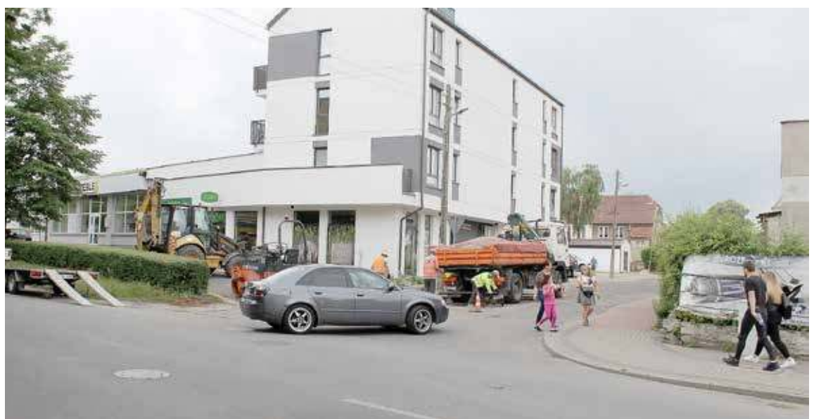
Przejścia dla pieszych tu nie ma, choć odcinek ten jest ruchliwy
