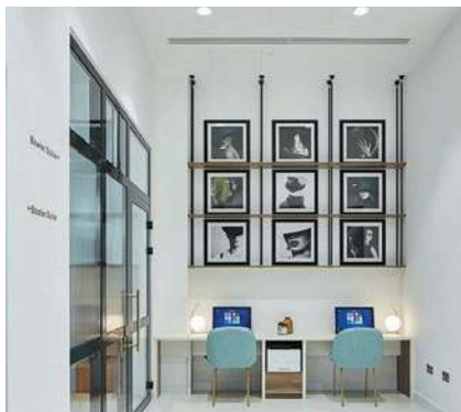
Fot. 2. Nawiewnik szczelinowy zastosowany w przestrzeni wspólnej do pracy cichej w hotelu w Luton (Wlk. Brytania)
