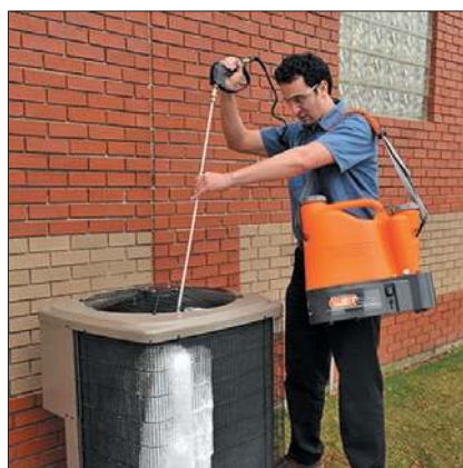
Fot. 6. Myjka (hydronetka) zapewniające mycie lameli parowników pod ciśnieniem zapewniającym zarówno skuteczność, jak i ochronę elementów wymiennika
