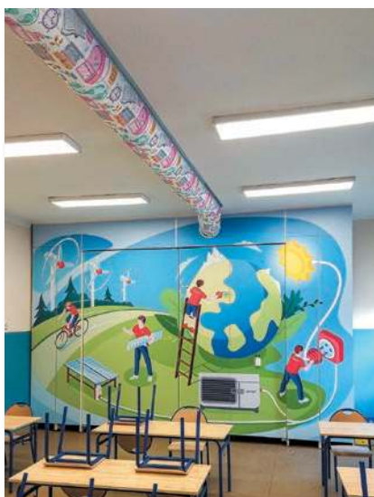
Fot. 7. Przykład kanału tekstylnego zastosowanego w sali szkolnej Źródło: FabricAir
