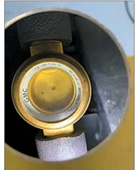
Rys. 4. Widok czystego czynnika chłodniczego w obiegu maszyny do płukania w końcowej fazie procesu usuwania zanieczyszczeń z instalacji
