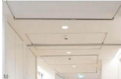
Fot. 4. Nawiewnik szczelinowy ze skrzynką rozprężną zapewniającą znaczne wyciszenie urządzenia
