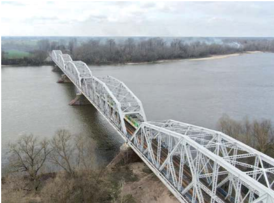
W ramach inwestycji, za niemal 10 mln zł ze środków własnych PKP PLK, zmodernizowany zostanie most kolejowy nad Wisłą (fot. PKP PLK)
